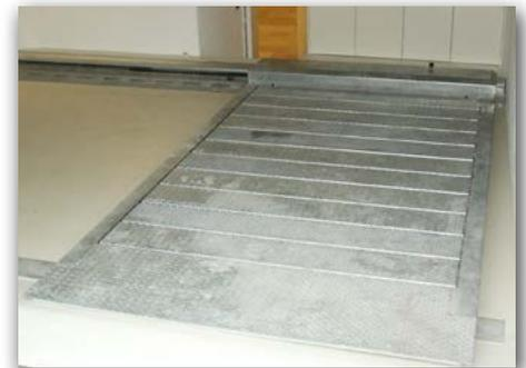
**BEKA Verschiebepaletten HQ** verschieben PKW quer zur Fahrtrichtung. Durch Anwahl eines Stellplatzes, können die Paletten automatisch zur gewünschten Position bewegt werden.
