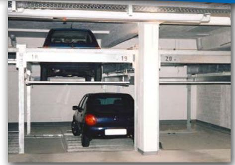
**BEKA Automatisierte Parksysteme und Reihenparker** kombinieren Horizontal- und Vertikalbewegung. Durch die SPS-Steuerung sind einzelne Stellplätze gezielt abrufbar. Der zur Verfügung stehende Raum wird optimiert genutzt.
