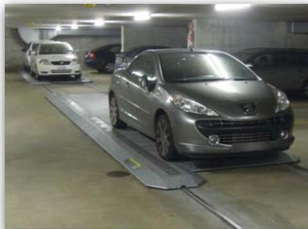
**BEKA Verschiebepaletten HL** verschieben Fahrzeuge längs zur Fahrtrichtung; Die Verschiebepaletten nehmen zwischen einem und vier PKW auf und Verschieben diese horizontal um Freiraum für weitere PKW zu schaffen.
