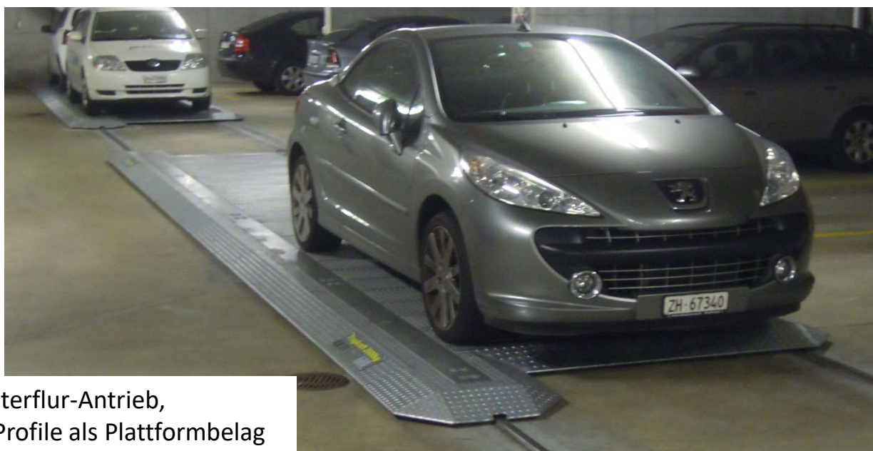
Überflur-Antrieb, nachträgliche Montage
