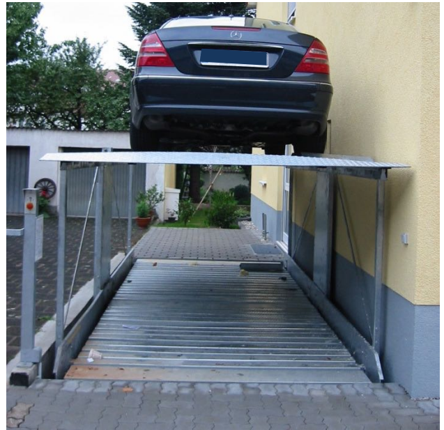
Versenkgarage mit überstehendem Ständer. Oberer Belag: Tränenblech
